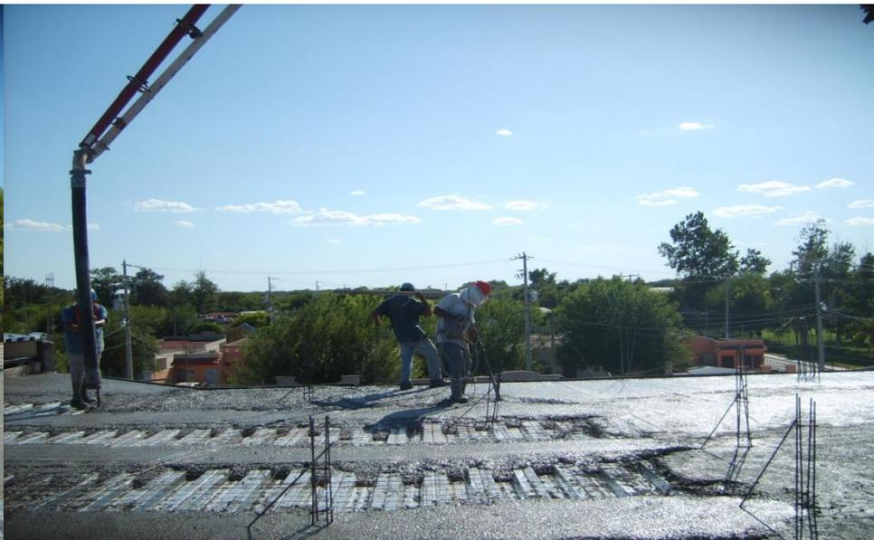
SUMINISTRO Y COLOCACION DE LOSA DE CONCRETO INCLUYE: MALLA ELECTROSOLDADA 6-6/10-10 Y LAMINA CALIBRE 24 (LOSA-ACERO) SECCION 3.
