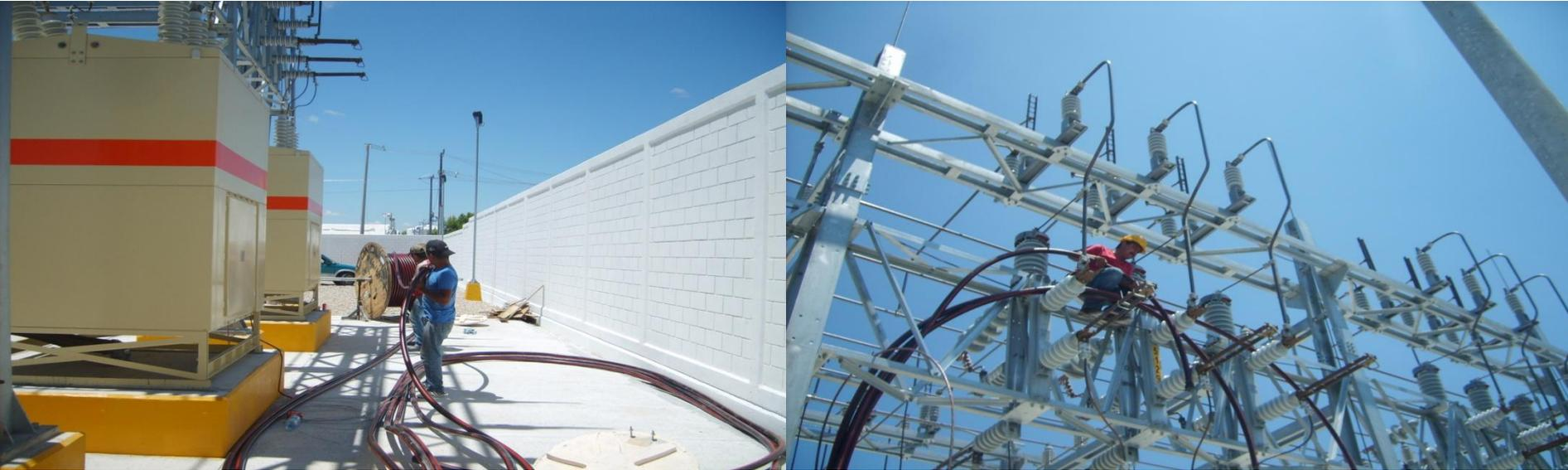
INSTALACION DE CABLE DE POTENCIA AISLADO A 35 Kv. CALIBRE 500 KCM. Y CABLE ACS DSA CALIBRE 7 NUM. 6
