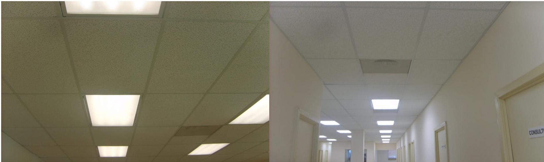
COLOCACION DE LUMINARIAS DE 4X32 , 3X32, 2X32 Y 2X17 WATTS
