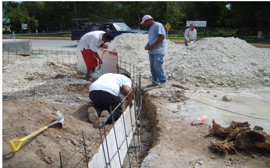
EXCAVACION, PLANTILLA, ARMADO, CIMBRADO Y COLADO DE DENTELLON Y RELLENO
